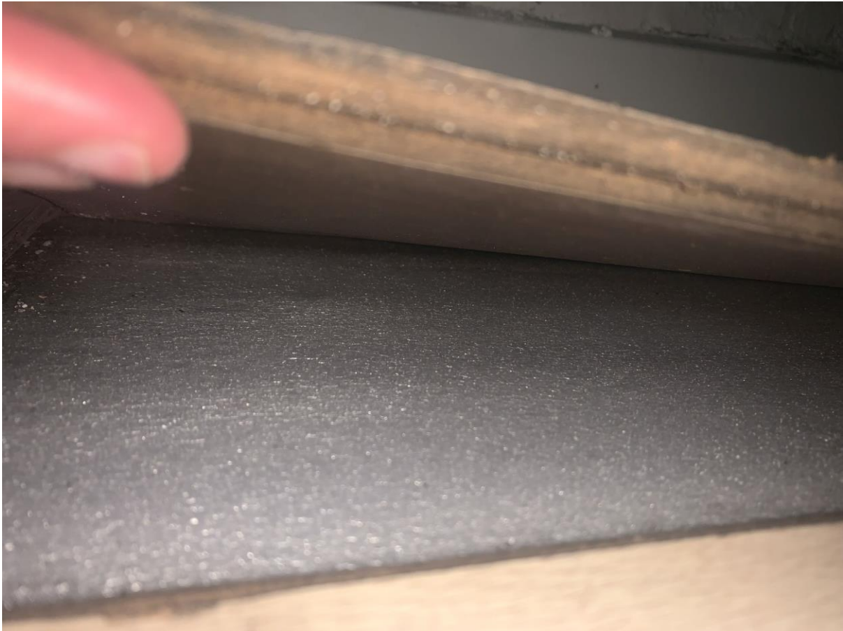
Skimmelprøve udtaget på underside af laminatbræt
